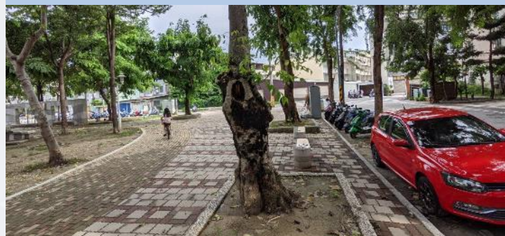
鄰里公園樹洞步道巡查
