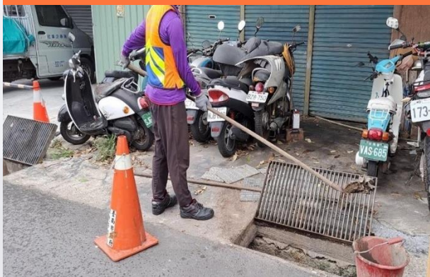
水溝積淤作業
